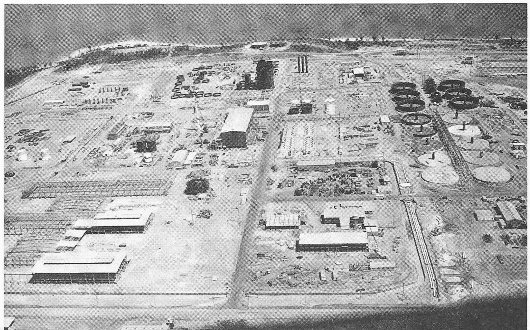
Bild 1. Fabrikansicht von Süden, Bauzustand Oktober 1970
