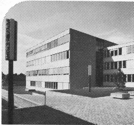
Gymnasium Oberwil BL, Bauzeit 1972/73 Klassentrakt für 580 Schüler. Flexible Grundrisse. Verbindungsbau mit Verwaltungstrakt, Turnhallen. Die nur 16monatige Bauzeit ersparte dem Kanton die Weiterführung teurer Provisorien. Architekten: G. Schwörer + P.Liner, dipl. Architekten, Liestal.
