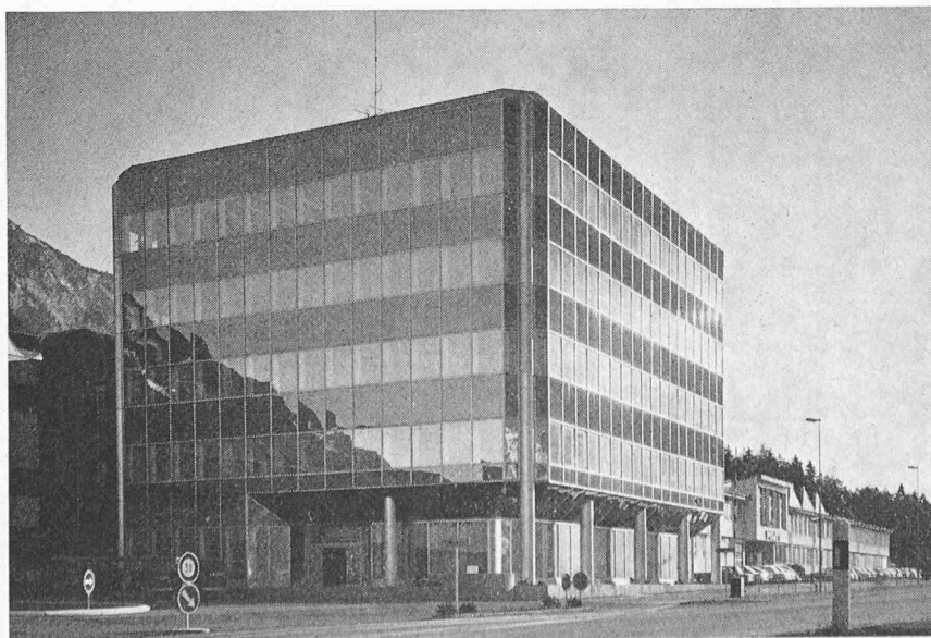
Verwaltungsgebäude der Hilti AG, Schaan FL, mit zurückgesetzter Eingangspartie. Architekten: Burckhardt & Partner, Basel
