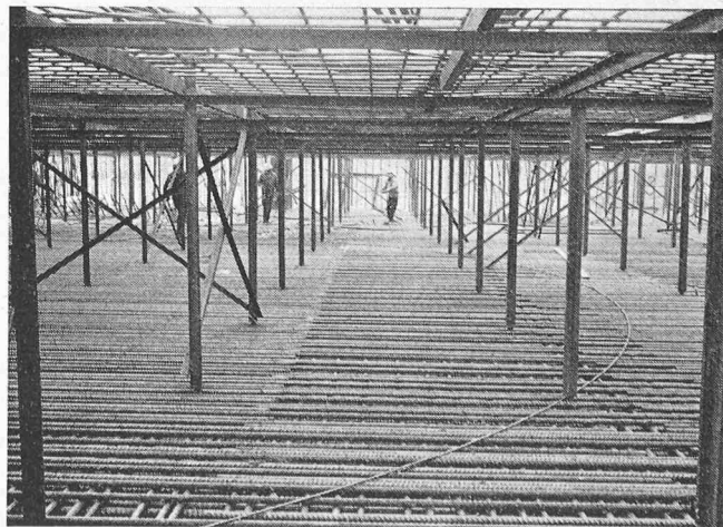
Bild 7. Fundamentplatte des Reaktorgebäudes. Abstützkonstruktion für die obere Armierung
