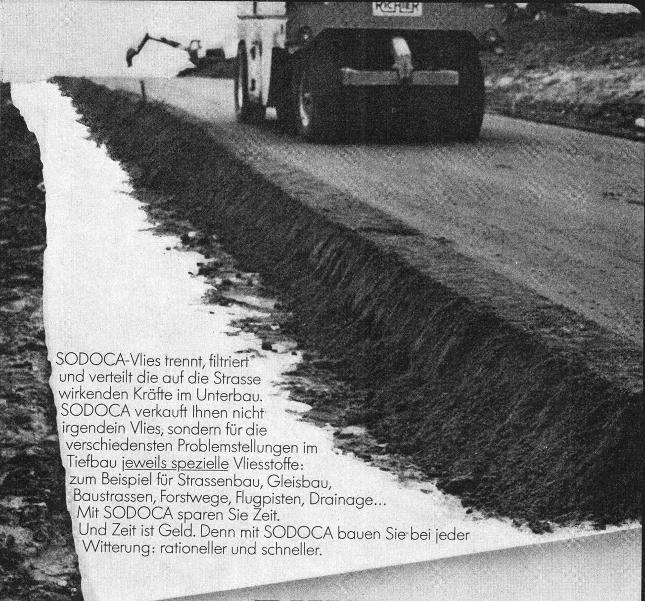
SODOCA-Vlies trennt, filtriert und verteilt die auf die Strasse wirkenden Kräfte im Unterbau. SODOCA verkauft Ihnen nicht irgendein Vlies, sondern für die verschiedensten Problemstellungen im Tiefbau jeweils spezielle Vliesstoffe: zum Beispiel für Strassenbau, Gleisbau, Baustrassen, Forstwege, Flugpisten, Drainage... Mit SODOCA sparen Sie Zeit. Und Zeit ist Geld. Denn mit SODOCA bauen Sie bei jeder Witterung: rationeller und schneller.
