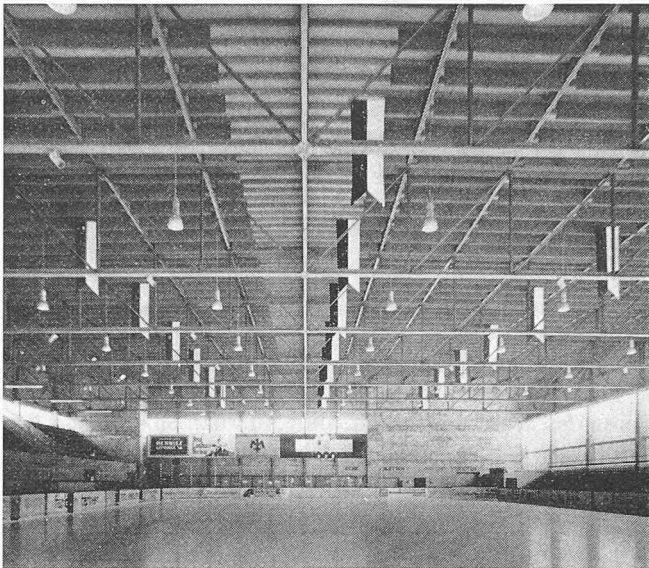
Sportzentrum Herisau. Innenansicht der Eishalle. Die Schallschutzschikanen an der Decke sind sichtbar
