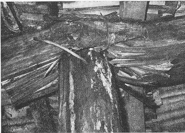
Bild 8. Drückerscheinungen im Sondierstollen im Nordabschnitt des «Mesozoikums»
