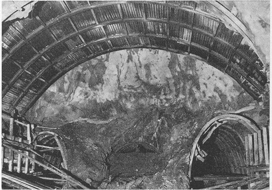
Bild 6. Ansatzstelle des Kalottenvortriebes mit Messerschild im Haupttunnel im Norden des «Mesozoikums». In der Achse ist die Kalotte des Sondierstollens ersichtlich
