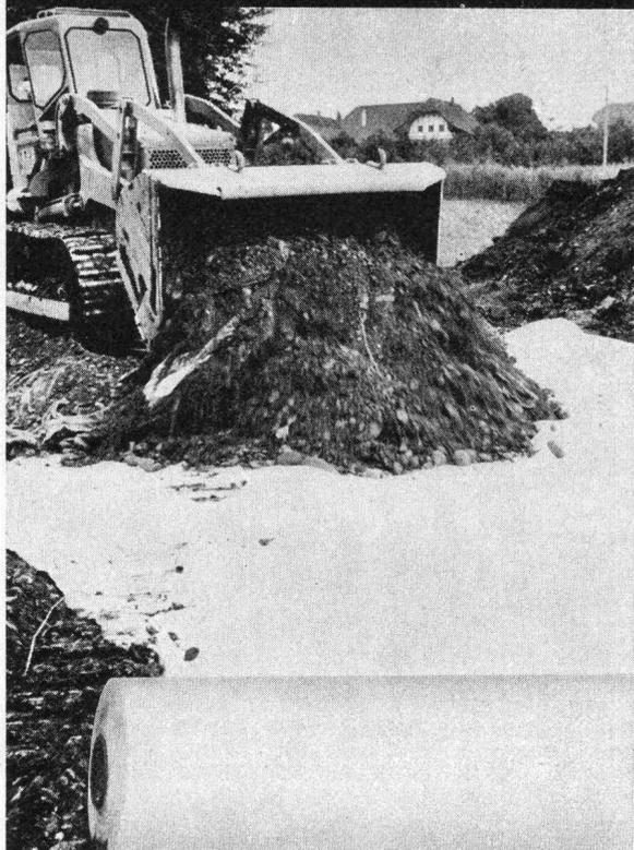
SODOCA-Vlies aus UV-stabilisiertem Polypropylen trennt, filtert und verteilt die auf die Strasse wirkenden Kräfte im Unterbau.
