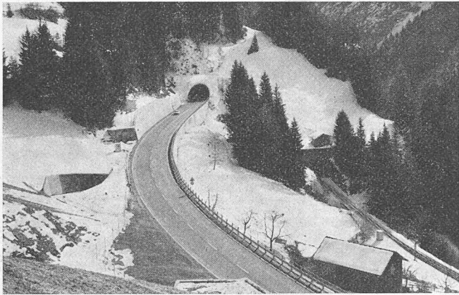
Bild 6. Westportal des Alvascheintunnels
