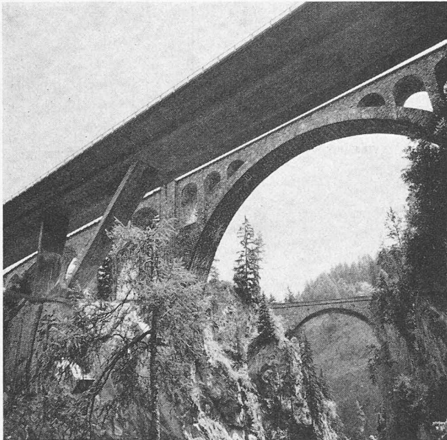
Bild 1. Alle drei Brücken über die Albulaschlucht aus der Schinschlucht gesehen
