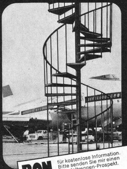
Nottreppe am neuen Fingerdock in Kloten
