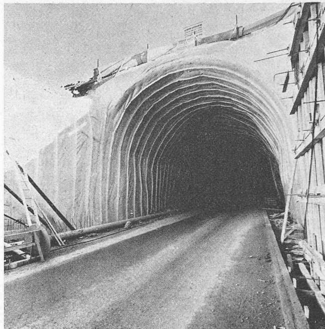
Bild 5. Tunnel Gleinalm-Nord (Österreich). Tunnelabdichtung mit Kunststoffdichtungsbahnen aus PVC auf Gunitunterlage. Stossverbindungen als Stehfalz mit Doppelnah (druckluftgeprüft). Portalpartie
