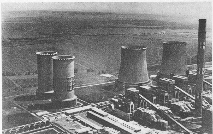
Bild 1. Gesamtansicht des 800-MW-Kraftwerkes Gagarin in Gyöngyös, Ungarn. In der linken unteren Ecke ist die Nasskühlanlage für den Block III. Die zwei zylindrischen Türme kühlen den Abdampf der Blöcke I und II. Die beiden grossen hyperbolischen Türme kühlen den Abdampf der Blöcke IV und V
