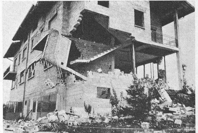
Bild 11 (nach dem 15. Sept.). Rechts: Wohnhaus mit Werkstatt bei Artegna nach erneuter Bebenbeanspruchung. Infolge der weiteren Bebenbelastung stürzte die Stirnwand im Mittelgeschoss ein. Die Tür- und Fensterpfosten der Längswände wurden zermalmt und brachen teilweise ein. Die Schubfestigkeit dieser Betonhohlsteinwände war gering, da der Mörtel in den Lagerfugen keine Verzahnung der übereinanderliegenden Schichten bewirkte
