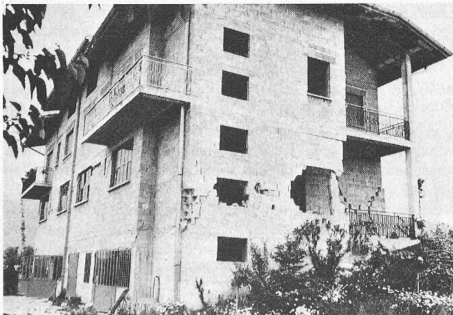
Bild 11 (nach dem 15. Sept.). Rechts: Wohnhaus mit Werkstatt bei Artegna nach erneuter Bebenbeanspruchung. Infolge der weiteren Bebenbelastung stürzte die Stirnwand im Mittelgeschoss ein. Die Tür- und Fensterpfosten der Längswände wurden zermalmt und brachen teilweise ein. Die Schubfestigkeit dieser Betonhohlsteinwände war gering, da der Mörtel in den Lagerfugen keine Verzahnung der übereinanderliegenden Schichten bewirkte
