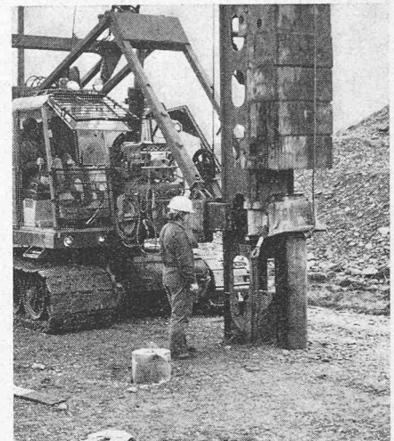
Bild 8. Rammern der Pfähle
