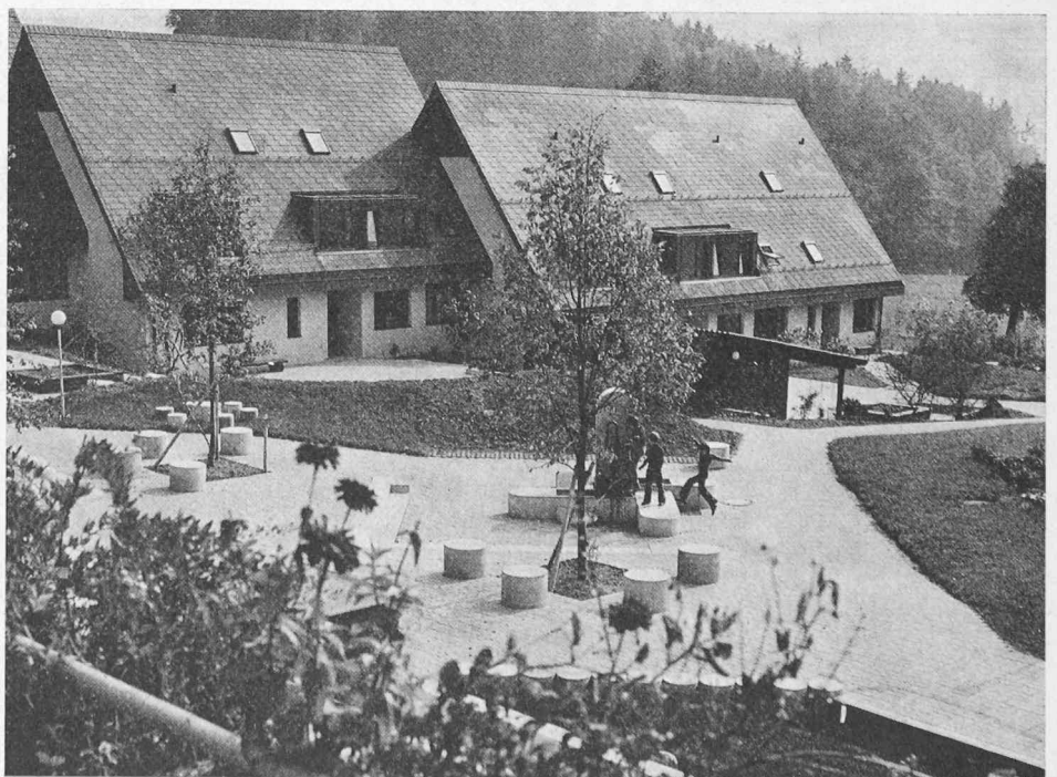
Pestalozziheim Buechweid in Russikon. Blick vom Hauptgebäude auf die Gruppenhäuser 7 und 8, anschliessend an das Gruppenhaus 8 befindet sich im gleichen Kubus ein Erzieherwohnhaus (rechts)
