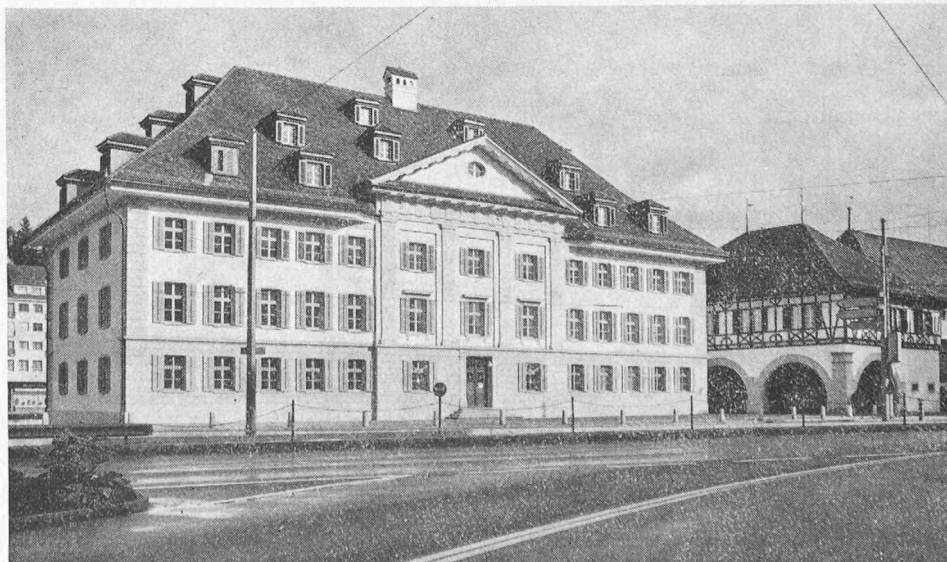
Das rekonstruierte Waisenhaus bei der Spreuerbrücke, rechts der aufgestockte Herrenkeller und das alte Zeughaus
