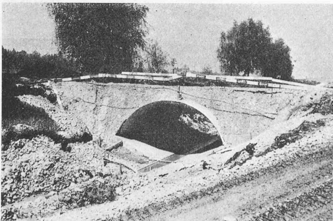
Durchlass für Vorflutkanal im Grossen Moos (BE). System Armcoc mit Verkleidung
