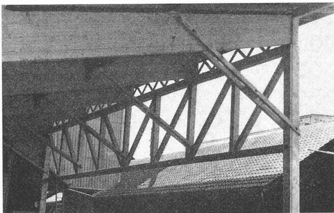
Bild 4. Fachwerk aus verleimten Einzelteilen. In den Knotenpunkten sind Stahllamellen eingeleimt, die über einen Stahlbolzen verbunden sind. Diese Lamellen wurden vorher mittels Araldit mit Fichtenholz furniert. Baujahr 1948. Hersteller: Gribi & Co. AG, Burgdorf
