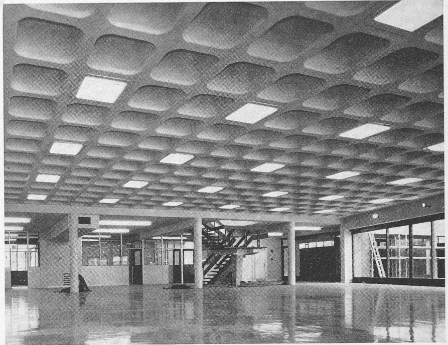
Bild 12. Die Kassettendecke kann zur Aufnahme von Beleuchtungskörpern herangezogen werden
