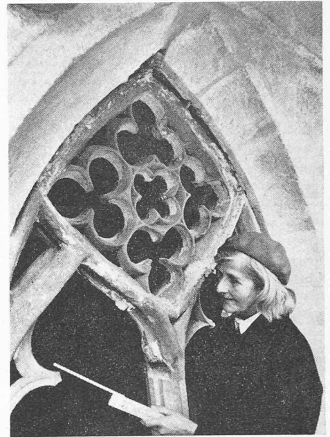
Links: Entdeckung eines ursprünglichen Kirchenfensters im Dachraum über der Dreifaltigkeitskapelle
