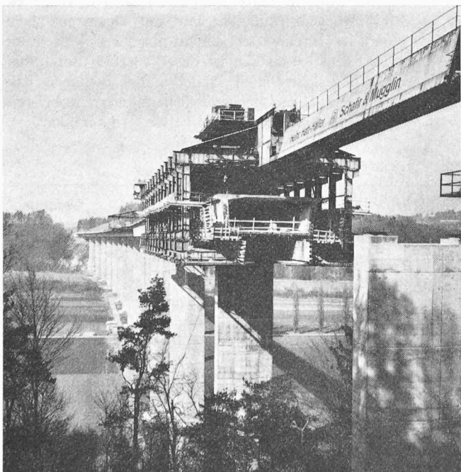
Bild 8 (links). Das Gerüst steht im Feld 13, unmittelbar nach dem Absenken, seitlichen Ausschieben und Hinunterklappen der Schalung. Der hundert Prozent vorgespannte Kastenträger ist bereit zur Aufnahme der grossen Gerüstlasten
