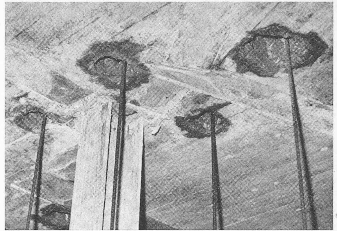
Hängestangen für Deckenschalung
