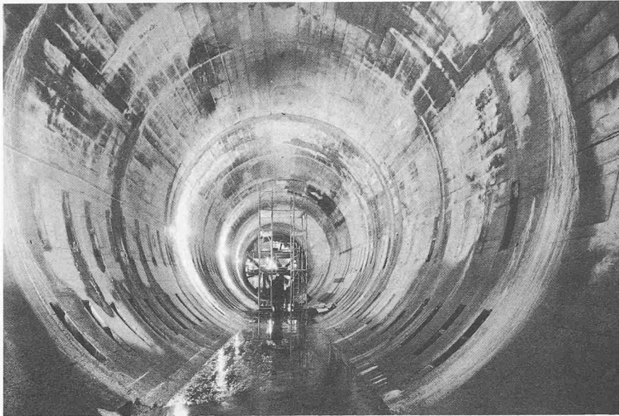
Fig. 6. Tronçon A après bétonnage Section A after concreting
