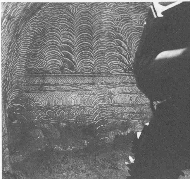
Bild 23. Gefräste Vortriebsbrust im Molassefels des Entlastungsstollens
