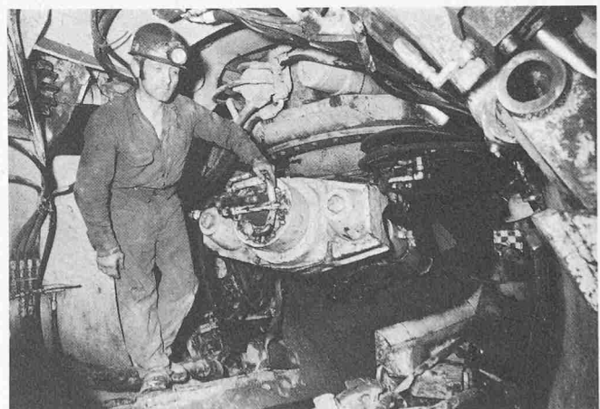
Bild 12. Schildmaschine im Vortrieb
