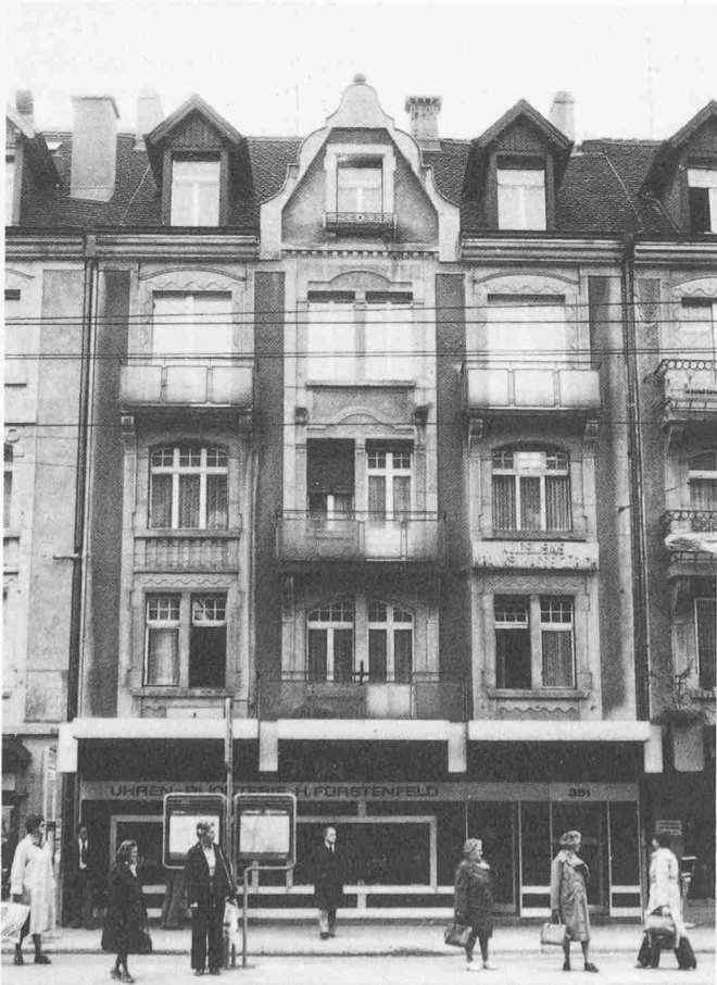
Bild 1. Zu renovierende Fassade: Strassenseite
