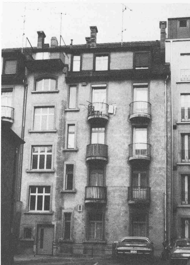
Bild 2. Zu renovierende Fassade: Hofseite
