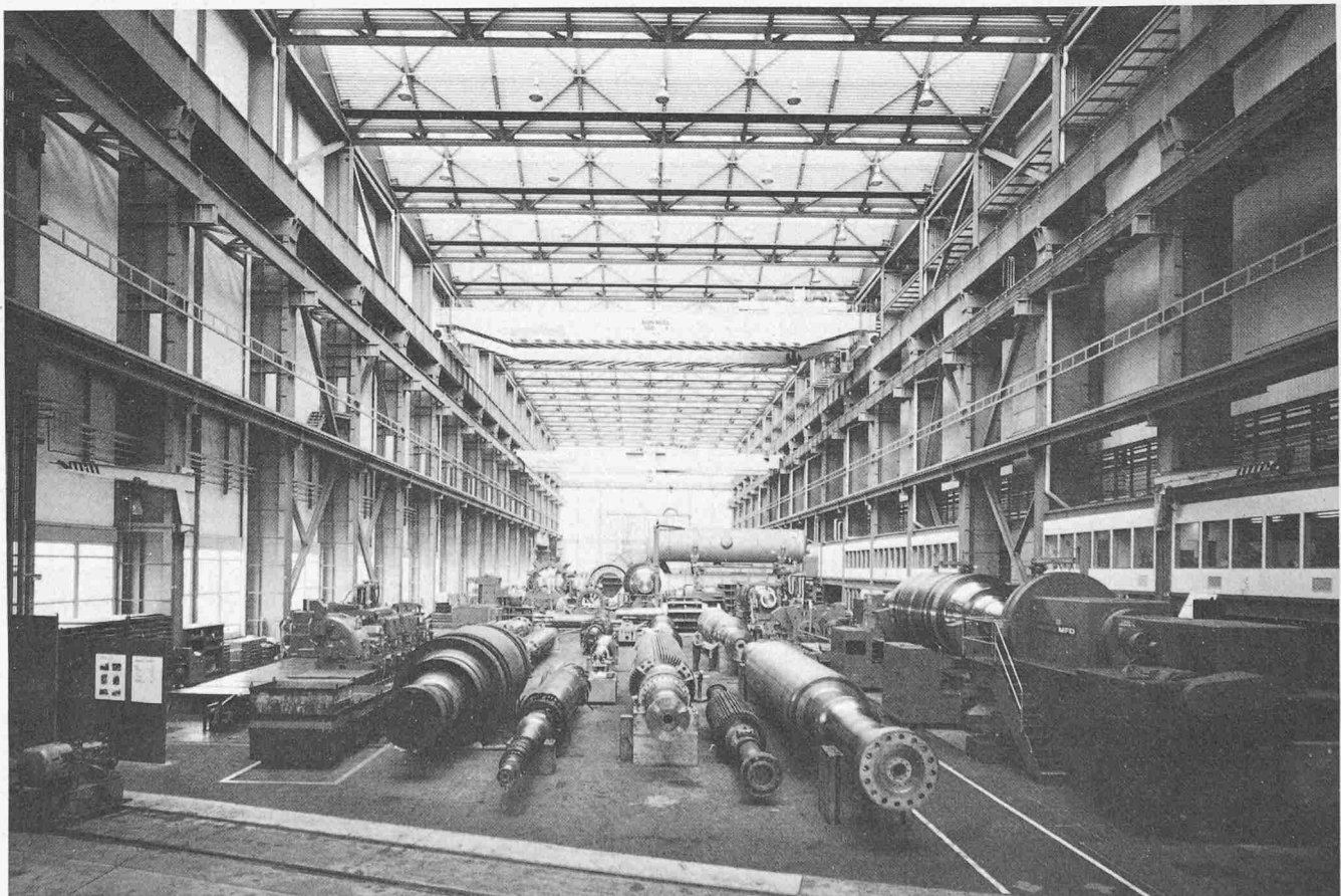
Bild 1. Blick in die neue Fabrikationshalle
