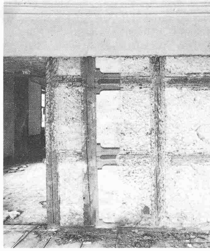
Freigelegte Riegelbemalung aus der Entstehungszeit
