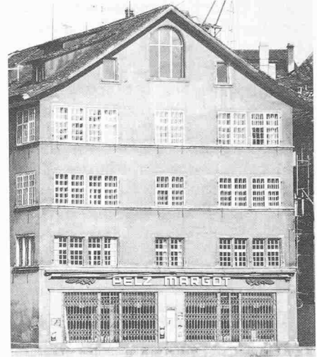
Das «Neuhaus» vor der Restaurierung 1976
