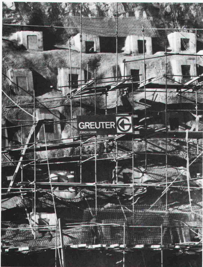
Felssicherung Dangernfluh, N2 (Eptingen)
