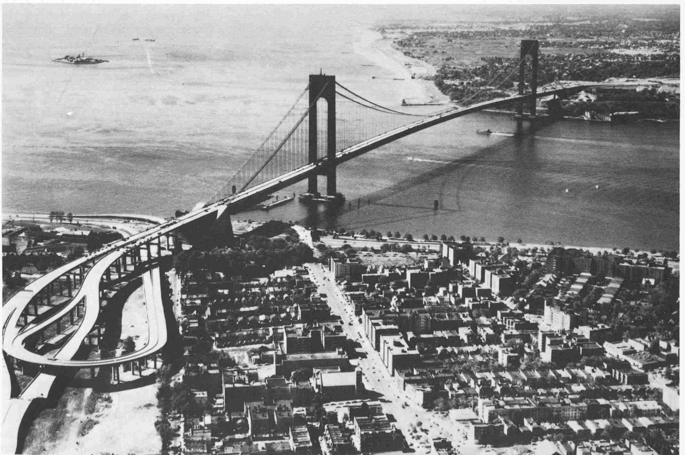
Verrazano Narrows Bridge, 21. November 1964 eröffnet; Mittelspannweite: 1298 m, zwölf Fahrbahnen auf zwei Ebenen
