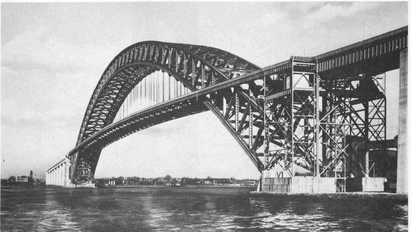
Bild 10. Bayonne Bridge eröffnet 15. November 1931
