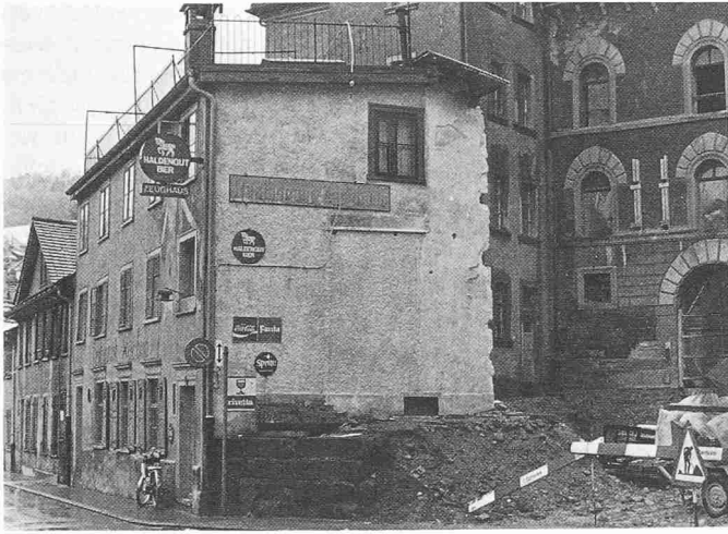
Links: Restaurant «Zeughaus» vor dem Umbau. Die schlechten Proportionen der Westfassade und die später aufgebaute Zinne wirken ausgesprochen unschön. Rechts: Blick auf das Sockelgeschoss des Nordflügels des Regierungsgebäudes und die historische Trennmauer, welche 1567 von Abtei und Stadt erstellt wurden. Das an die Mauer angebaute Restaurant «Zeughaus» wurde um ein Stockwerk reduziert. Dadurch erhielt es wieder seine ursprüngliche, ansprechende Form mit Ziegeldach. Der unschöne Anbau (Hintergrund Mitte) wird im Zuge von Umbauarbeiten im Regierungsgebäude demnächst abgebrochen
