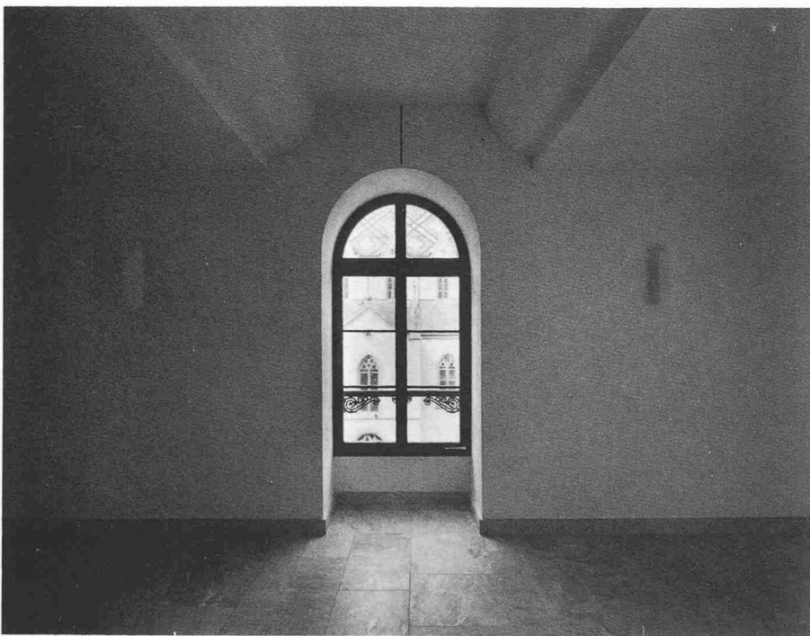
Korridor im 2. Geschoss (Büros des Kantonsgerichtes). Die kräftig profilierte Decke berücksichtigt und betont die vorhandenen Fensteröffnungen
