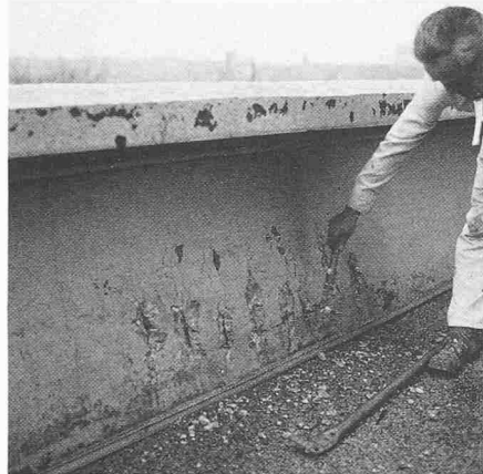
Abgesprengte Betonteile über der Bewehrung müssen sorgfältig entfernt werden, damit die Bewehrung durch anstrichtechnische Behandlung vor weiterer Korrosion geschützt werden kann
