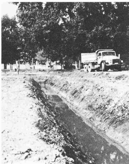
Bild 10. Voraushubgraben auf der Nordseite des Spezialtraktes zur Ableitung des in der Auffüllung (Kehricht) vorhandenen, isolierten Schmutzwassers
