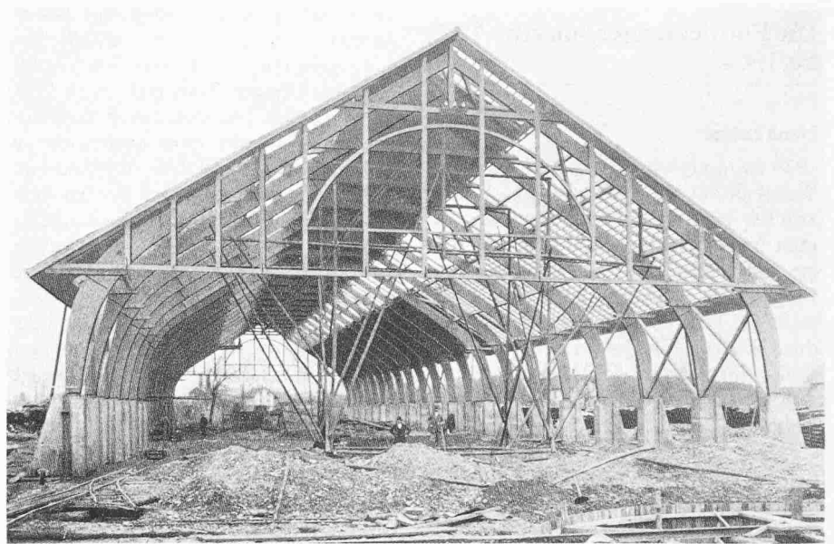
Bild 3. Werkhalle der Zellulosefabrik Attisholz, 1916. Stützweite 25 m [4]
