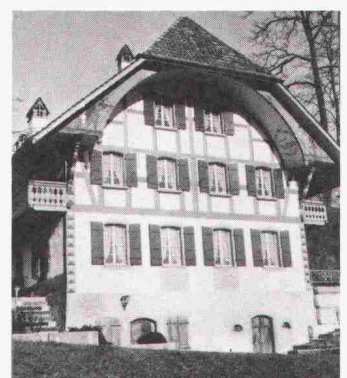
Der Wärmedämmputz eignet sich bei Renovierungen hervorragend (Riegelbauten)
