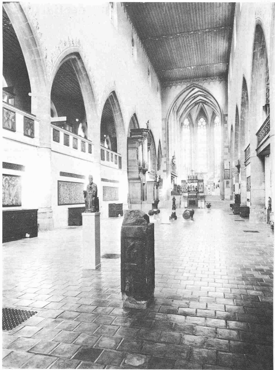
Bild 1. Innenansicht der Barfüsserkirche vor der Renovation. Man beachte an der rechten Pfeilerreihe (Achse C) die Verfärbung infolge Salzeinwirkung
