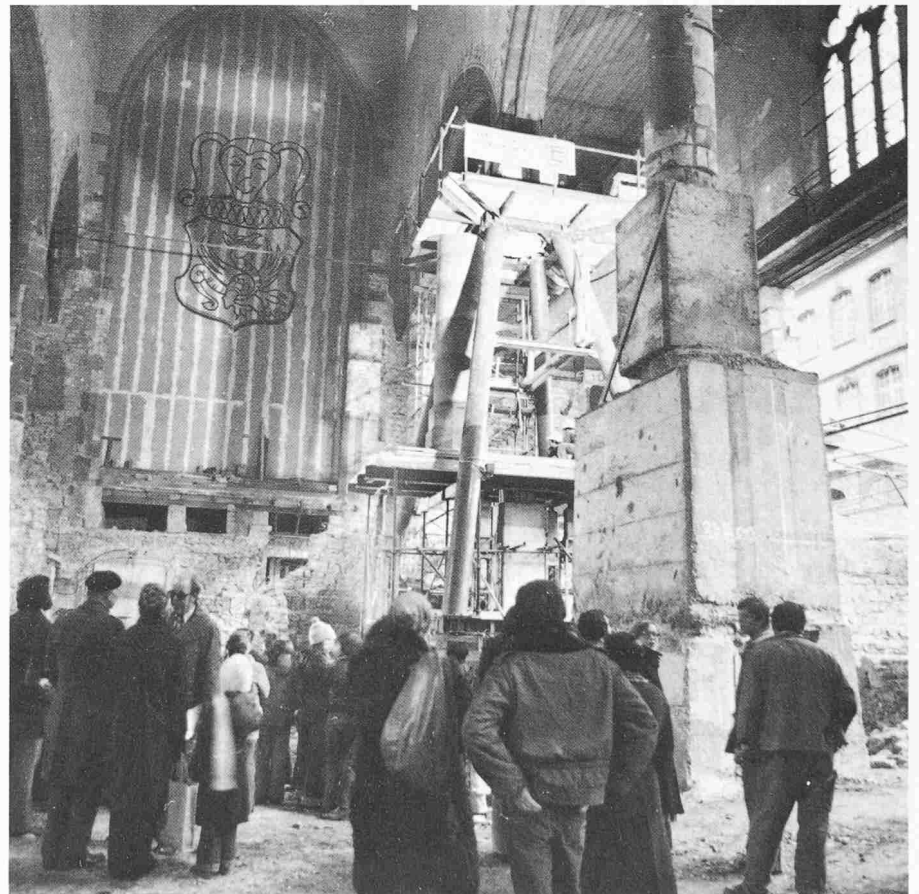
Bild 12. Pfeiler C 7. Der neue Buntsandstein-Pfeiler ist seitlich mit Hilfe eines Pneukranes zusammengebaut worden; nun wird er unter die Trennfuge eingefahren. Eine Schulklass schaut interessiert zu (Aufnahme: 16.12.76)
