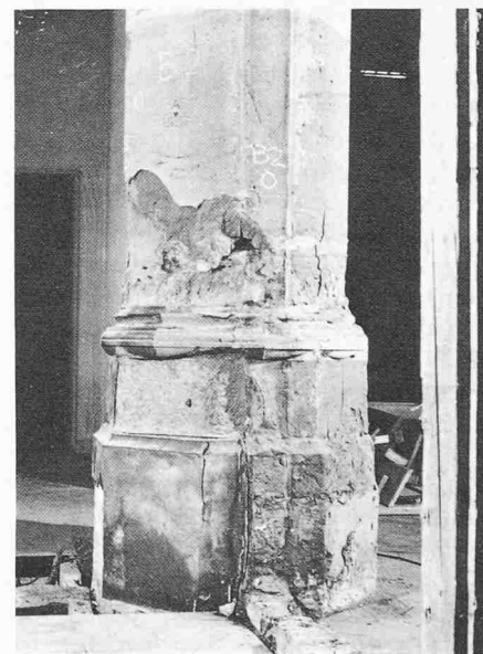
Bild 3. Zerstörungen an den Pfeilerbasen. Die wachsenden Salzkristalle sprengen das Korngefüge und erzeugen Spannungsrisse (Aufnahme: Mai 1975)
