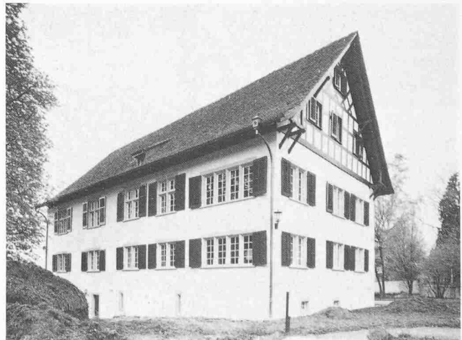
Nach der Restaurierung
