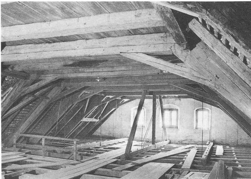
Liegender Dachstuhl mit Sprengwerk
