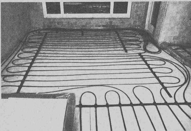
Auf der Wärmeisolation verlegte Unitex-Rohre, unmittelbar vor dem Einbringen des Unterlagsbodens. Beim Fenster sieht man deutlich die zur Kompensation des Kälteabfalles erhöhte Rohr-Konzentration.
