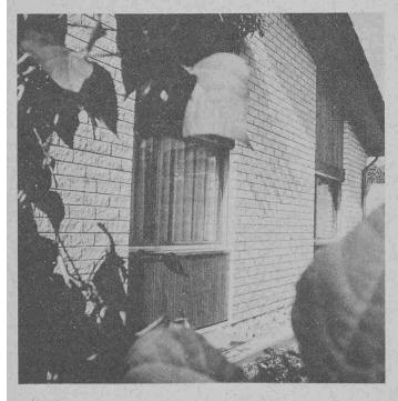
zeigt, die Möglichkeiten individueller, origineller Lösungen eröffnet. Ein bewährtes Material aus einheimischen, natürlichen Rohstoffen ist der Kalksandstein: ein masshaltiger, druckfester Mauerstein mit glatten Oberflächen, der klimatischen, statischen und bauphysikalischen Belastungen mit Leichtigkeit standhält. Als Neuheit stellt die Hard AG jetzt Hardit, einen Kalksandstein mit bruchrauher Sichtfläche, her. Was heisst bruchrauh? Was bietet der neue Baustein für Gestaltungsmöglichkeiten?
