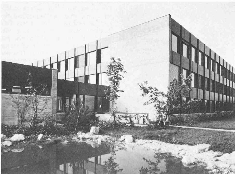
Nordwestecke des Klassentraktes mit Verbindungsteil zur Sporthalle
