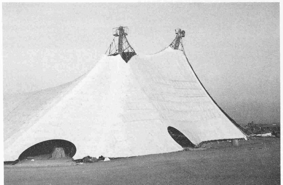
*Teilansicht der fertig montierten Aussenmembrane*
