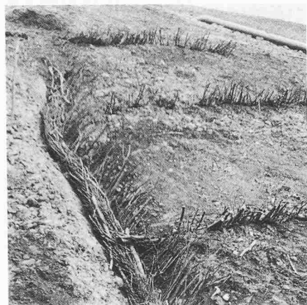
Bild 13. Kerzers N1. Aus dem Hang austretendes Wasser wurde mittels Bündelfaschinen in Ypsilon-Dränen abgeleitet (biotechnische Entwässerung)
