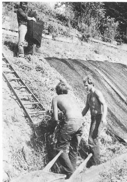
Bild 19. Nagelfluh Oberdiessbach. Über einer dicken Stroschicht als Mulch werden Strukturmatte ausgerollt. (Deckbauweise)
