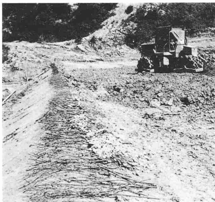
Bild 3. Salzweid N1. Auf ein rückwärts geneigtes Planum wurden Weiden und bewurzelte Pflanzen ausgelegt und darüber weitergeschüttet. (Stabilbauweise)
