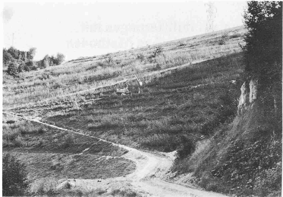
Bild 5. Salzweid N1. Nach drei Jahren Böschungsaufbau ist bereits auch die gesamte Oberfläche mit Heckenbuschlagen stabilisiert und begrünt. (Stabilbauweise)
