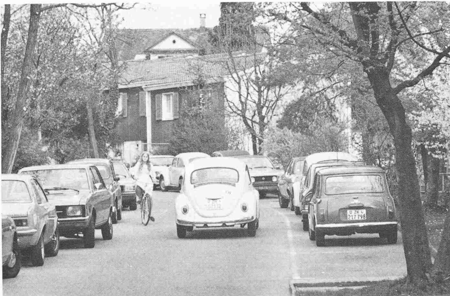
Bild 1. Viele Erschliessungsstrassen sind heute schon, wenn auch ungewollt, Einspurstrassen. Diese Strasse zum Beispiel hat eine Gesamtbreite von 7,4 m. Zieht man für die beidseitige Längsparkierung je 2,2 m ab, bleibt eine Fahrspur von 3 m Breite übrig. Mit dieser Strasse werden reibungslos etwa 90 Wohnungen mit etwa 110 Autos erschlossen. Im Gegensatz zu dieser «unfreiwilligen Einspurstrasse» wäre eine «geplante Einspurstrasse» mit den erforderlichen Parkplätzen ansprechend gestaltet, und sie würde richtig angeordnete Ausweichstellen aufweisen
