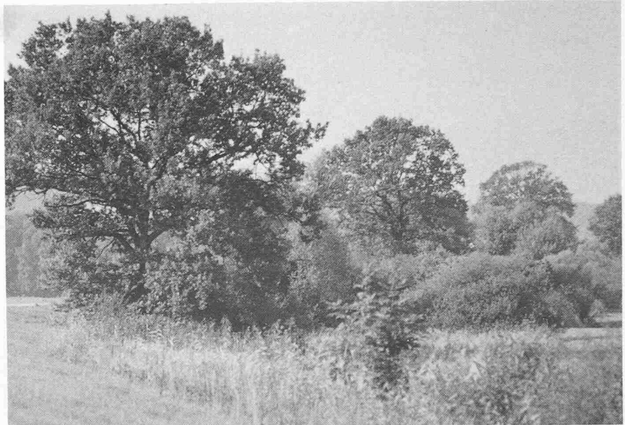
Bild 11. Reuss-Hochwasserschutzdamm (Bild: R. Maurer)
