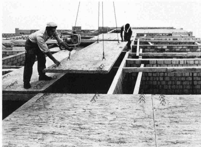
Versetzen einer PRELAM-Deckenplatte
