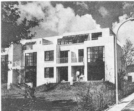
Stadhäuser als mehrgeschossige Einfamilienhäuser, auch ausserhalb des Altstadtbereiches. Naumburg, 1979
