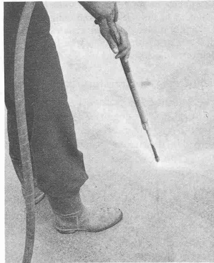
Bild 9. Reinigung der Betonoberfläche mit Hochdruckwasserstrahl (750 bar)
