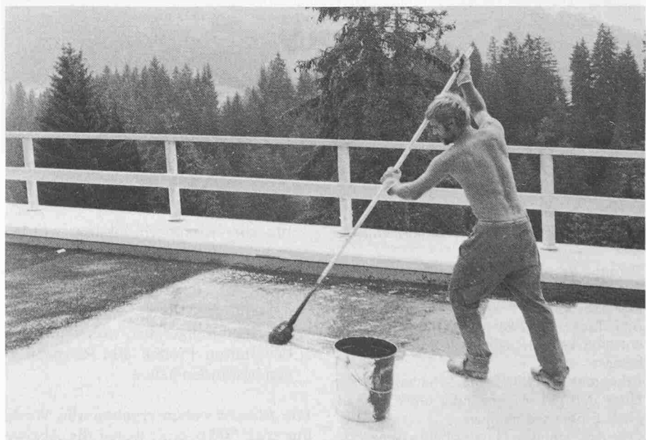
Bild 11. Auftragen der Abdichtung Efkaprene von Hand
