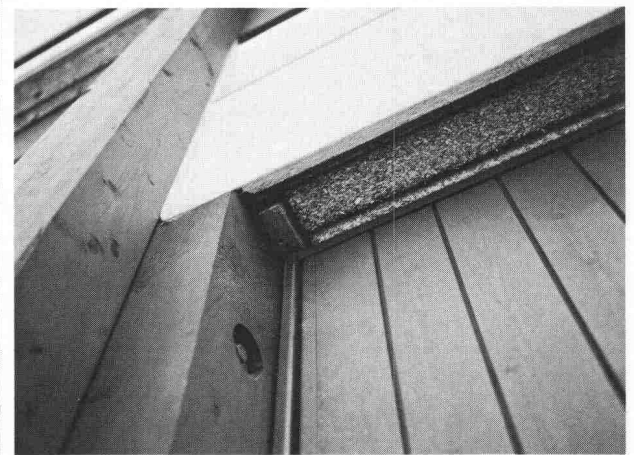
Detail Mehrzweckhalle, Haag SG
