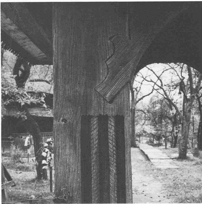
Kirche von Surdesti, 1721 n. Chr. Holzbauten ohne metallene Verbindungen zusammengefügt. Eingangstor mit Kannelur in Eichenholz und Schnitzwerk. Intakte Kultur
