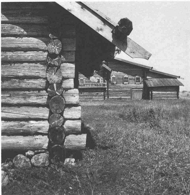
Ecklösung einer einfachen Scheune und im Hintergrund das Jelisarow-Haus, 1880 n. Chr.
