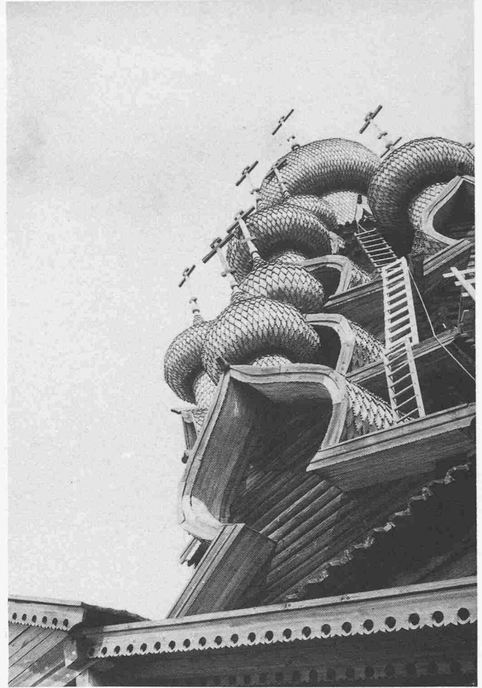
Preobraschenskaja-Sommerkirche von Kizhi. Grosser zentraler Zwiebelturm mit himmelstürmenden Kuppeln. Reiche Zimmermannsarbeit mit der Axt ohne einen einzigen Nagel errichtet
