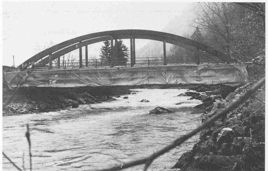
Bild 1. Gizenenbrücke mit untergehängtem Arbeitsgerüst
